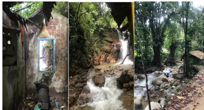
Gambar 2. Bangunan Air DAS Wae Pessy Negeri Hukurila
