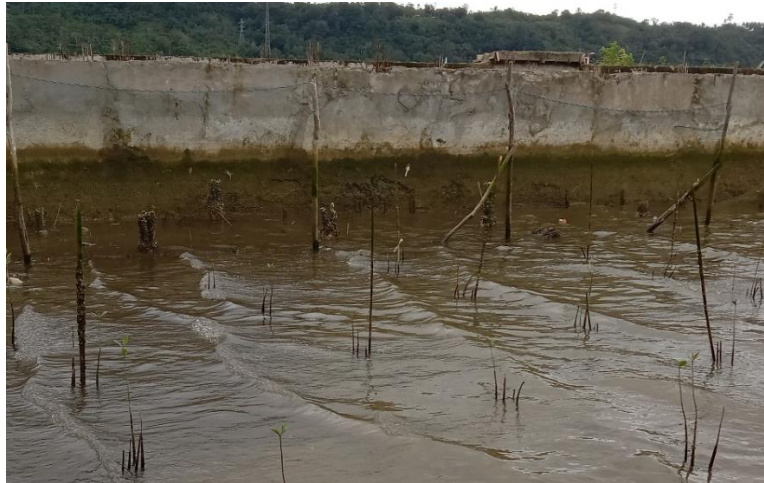
Gambar 7. Tanda batas air pasang pada taulud
